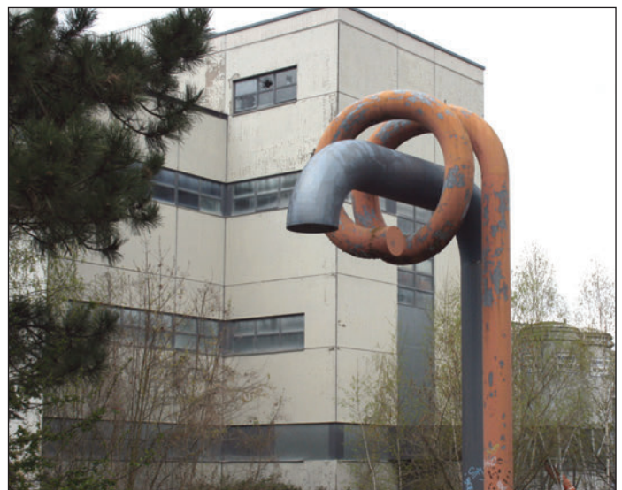
Ein (fast) vergessener Ort: das ehemalige Klärwerk Marienfelde, davor die „Röhrenskulptur“ des Designers und Architekten Fridtjof Schliephacke (1891-1930).
